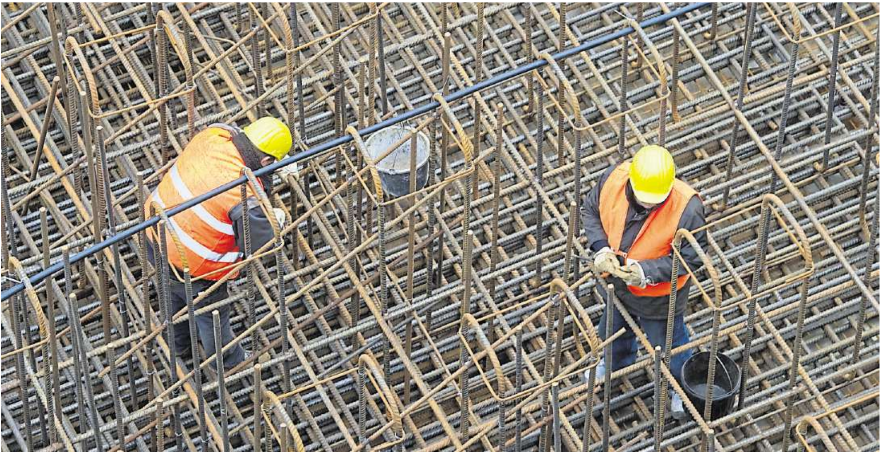
Der Bau ist eine Branche, in der Wanderarbeiter eingesetzt werden – oft in Subunternehmen.
